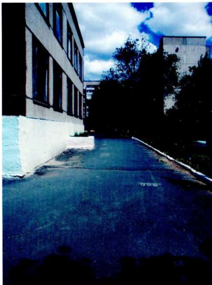
Территория, прилегающая к зданию (фото 3)
